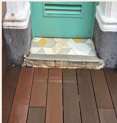
腳線油漆脫落
